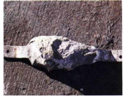
Анод, разрушенный коррозией
