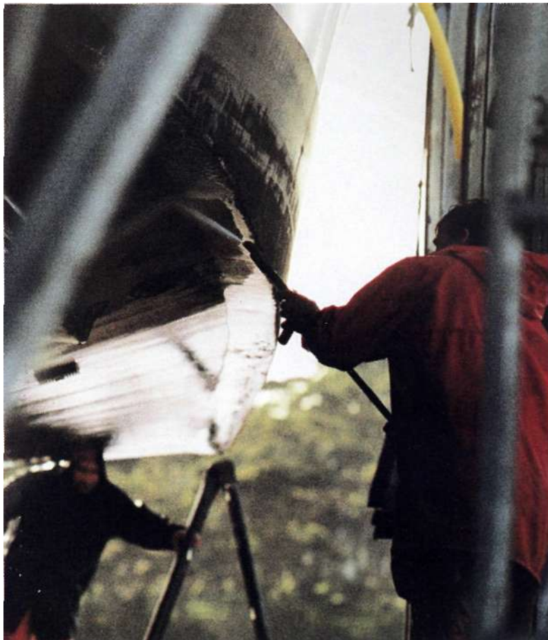
Для очистки ПОВАДНОЙ поверхности корпуса используется аппарат высокого давления
